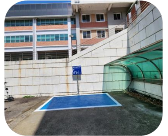
24) 33-37동 사이 이륜차 주차장
