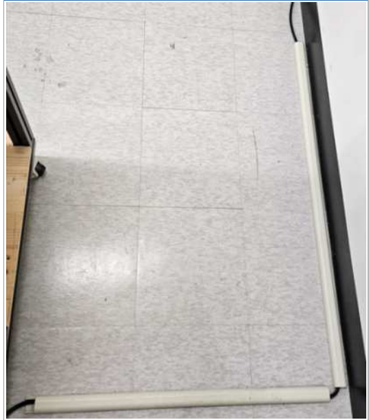
⑧ 바닥 배선 몰딩 처리
