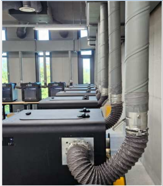
④ 3D 프린터 개별 환기설비 설치
