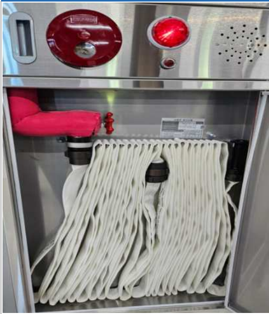
③ 옥내소화전 호스 보관 및 상태
