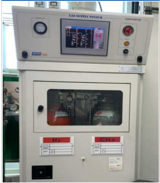
④ 실내 고압가스(가연성) 실린더 케비닛 설치
