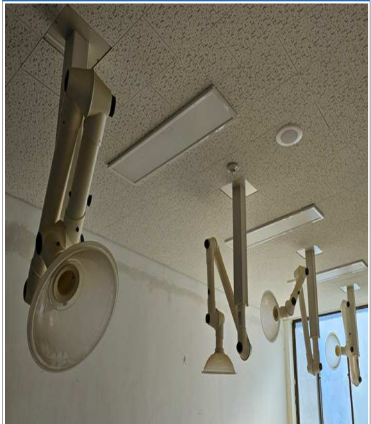
⑥ 국소배기장치 설치
