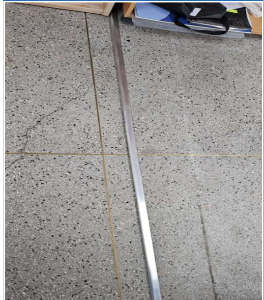
⑥ 바닥 배선 몰딩 처리
