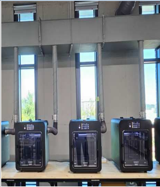
③ 3D 프린터 개별 환기설비 설치
