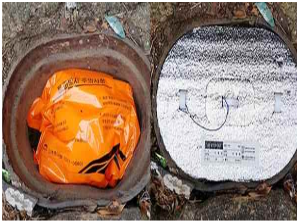
<상수도 계량기함 보온 조치>
