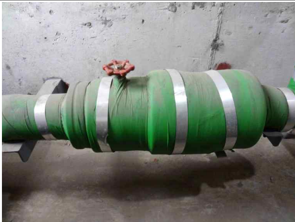
<물탱크실 급수관 밸브 보온재 설치>
