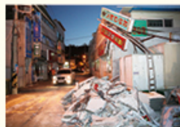
• 흥해읍 상가 외벽 난간 붕괴
