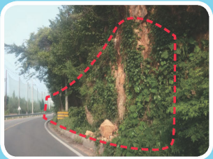
▶ 도로변 절개지 낙석지역 방호벽 설치사례
