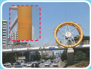
▶ 육교 주탑 내부 프레임 균열 및 부식 신고로 용접·보강한 사례
